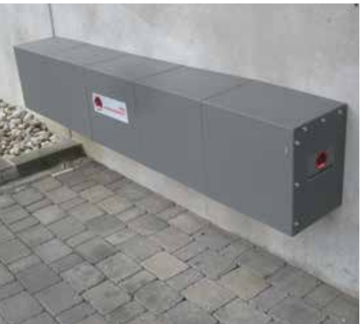
Wetterfeste Abdeckung zur Lagerung der Dammbalken
